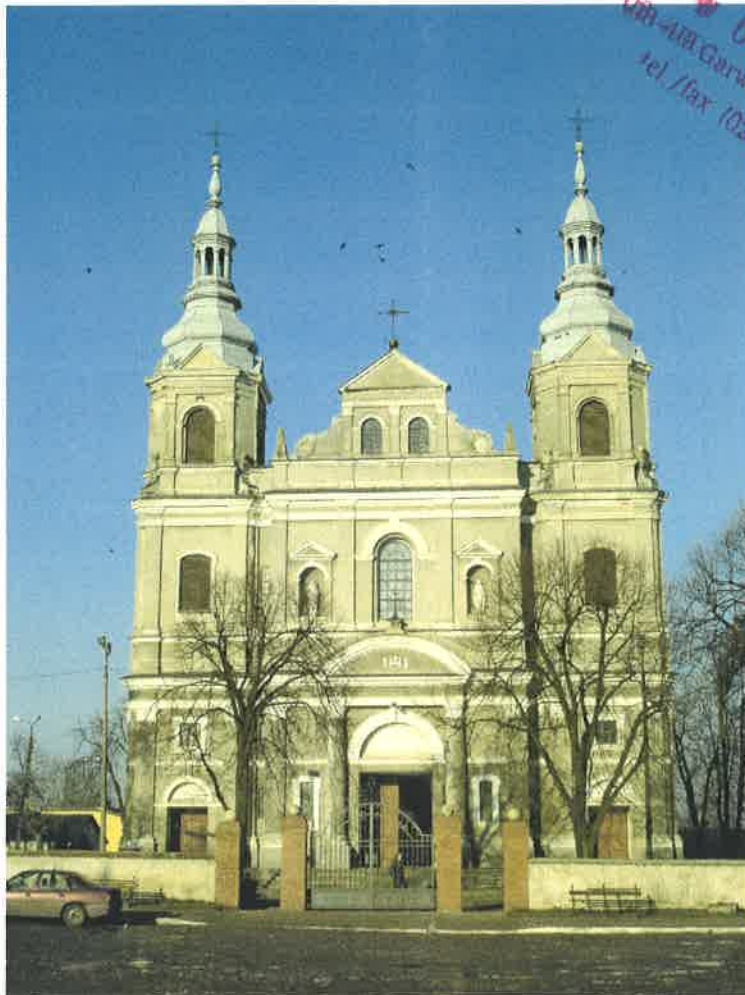
WIDOK FASADY KOŚCIOŁA
