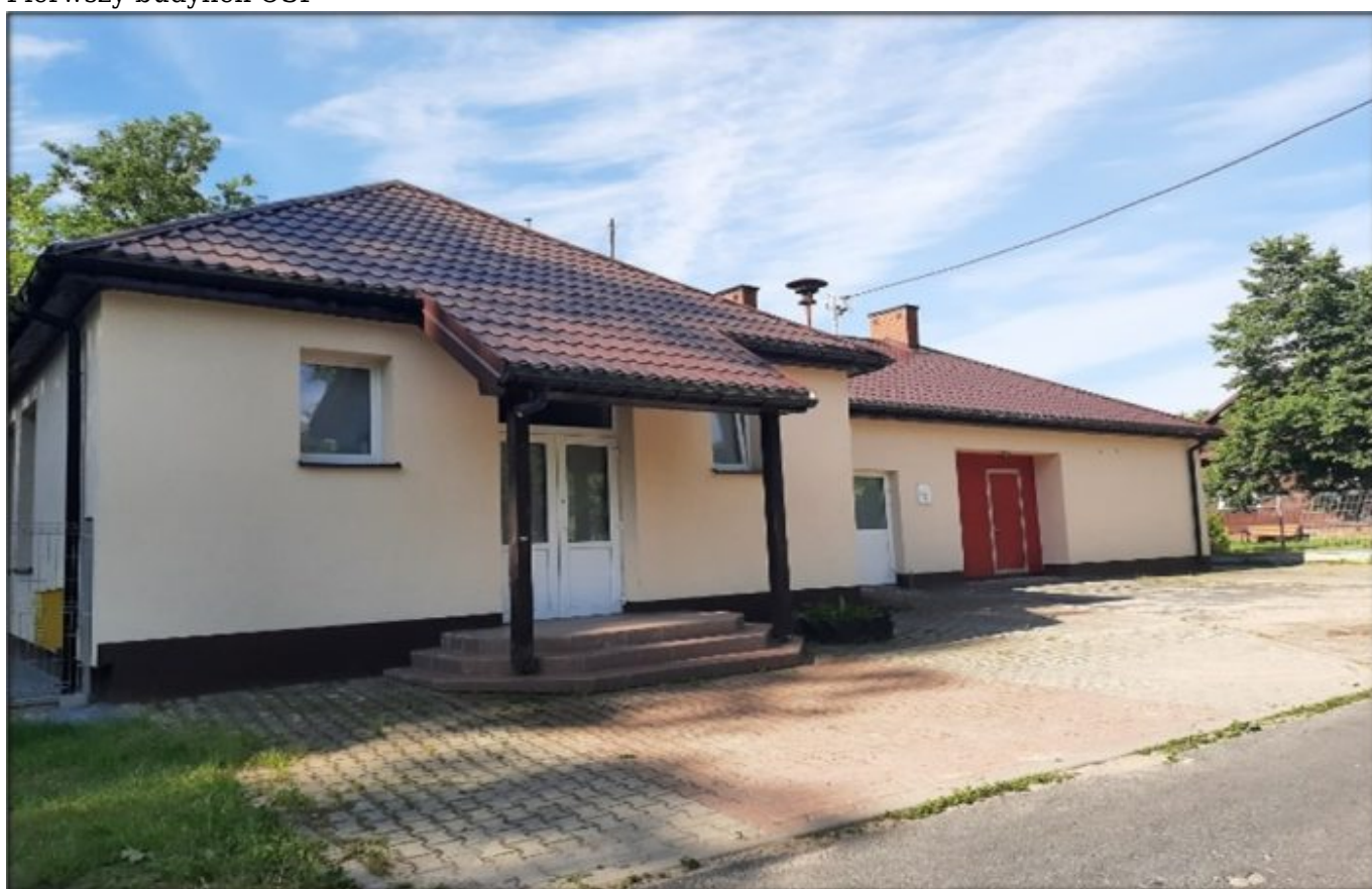
Budynek OSP obecnie
