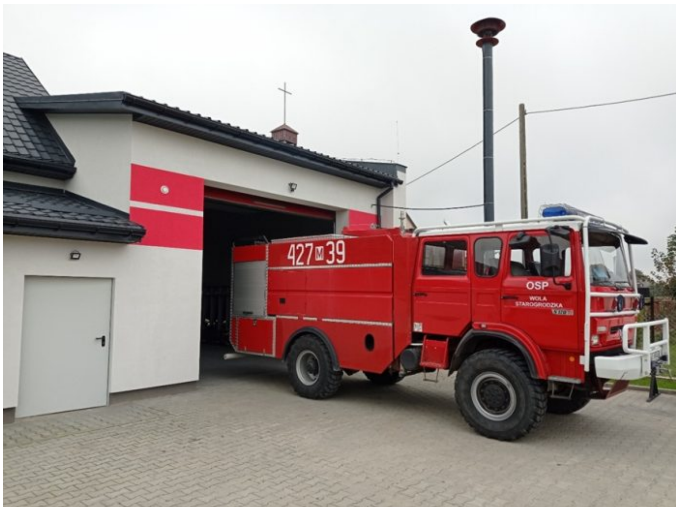
Wyremontowana część budynku OSP - wjazd do garażu
